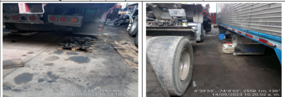
**Fotografía 3 y 4.** Placa de concreto con manchas e impregnación de productos derivados de hidrocarburos
